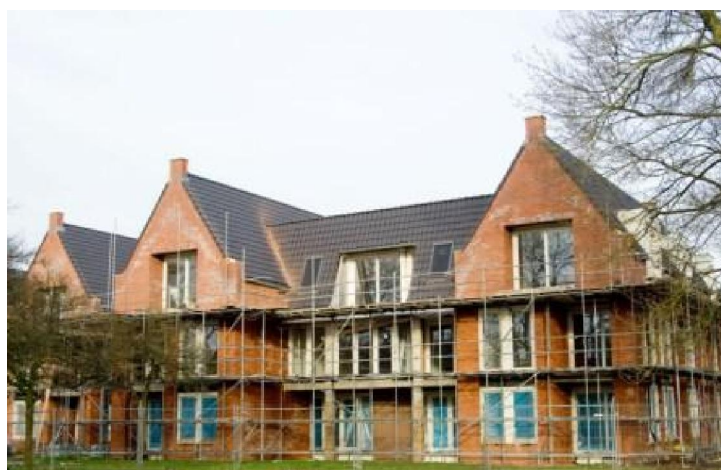
De appartementen in aanbouw
